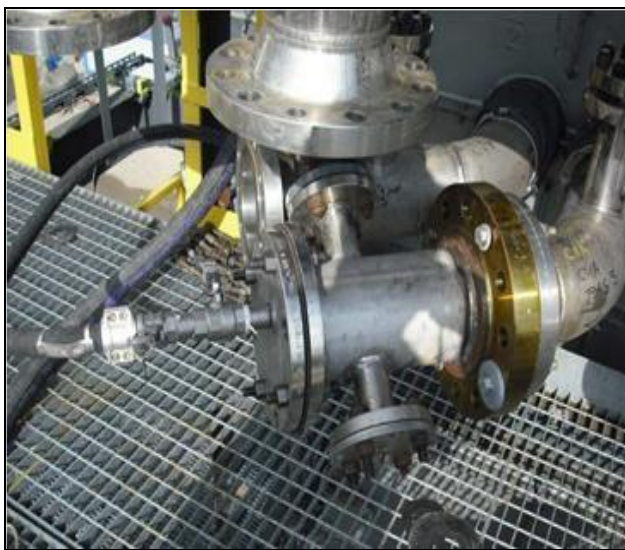
Rysunek 1. Stacja odbioru/startu kreta.
