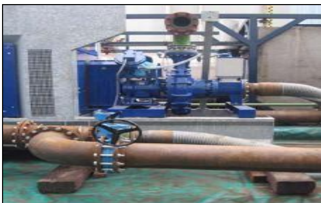
Rysunek 1. Instalowanie urządzeń do wykonania czyszczenia (pompa z napędem Diesel 850 m 3 /h).
