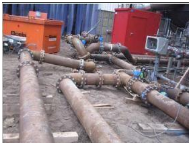
Rysunek 3. Tymczasowe instalacje dla wykonania czyszczenia chemicznego (DN 250).
