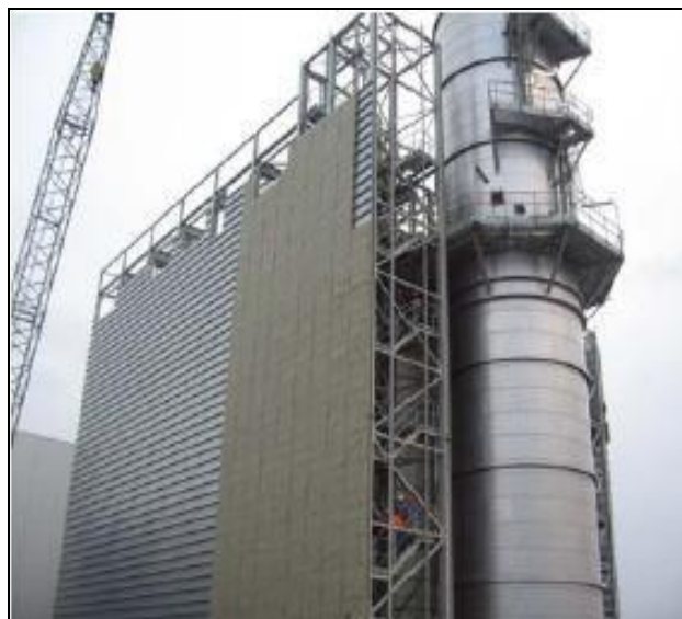
Rysunek 2. System 4 w Elektrowni Flevo podczas budowy.
