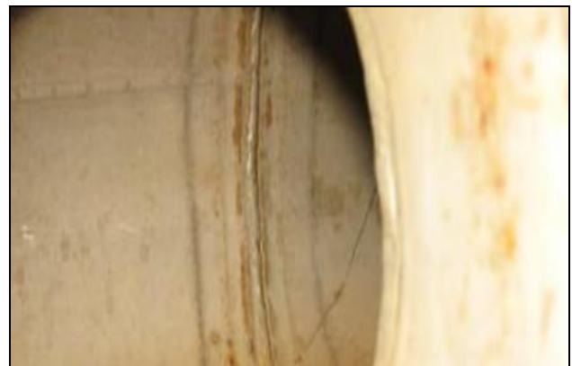
Rysunek 5. System 5PB - w miejscu podłączenia przenośnej pompy przed pasywacją - spoina spawalnicza i jej otoczenie pokryte licznymi produktami korozji.
