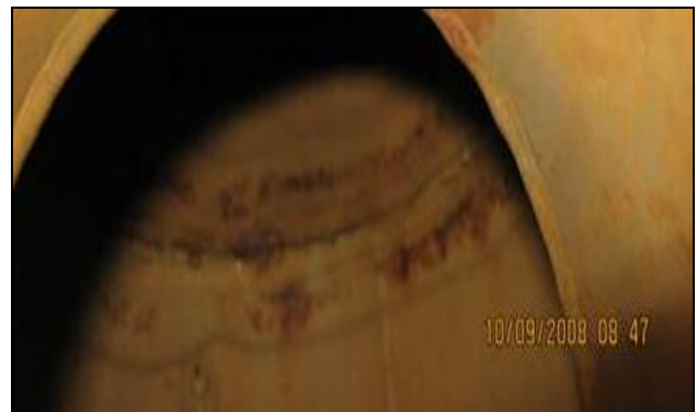
Rysunek 3. System 3 - przy połączeniu przenośnej pompy – spoina pokryta grubą warstwą produktów korozji.
