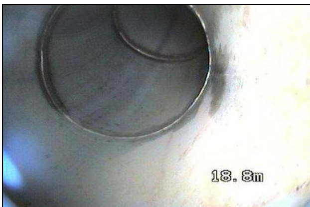
Rysunek 2. System 2 - dowód, że rurociąg był przez pewien czas zanurzony do połowy w kwasie, który powodował trawienie; dolna część spoiny spawalniczej wytrawiona, a górna część niezmiennona.
