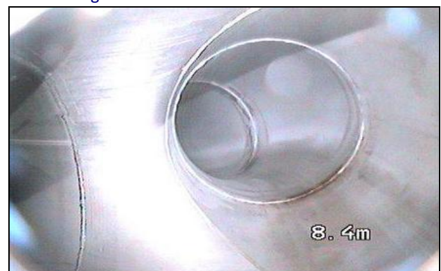
Rysunek 7. System 1 - (po obróbce powierzchni) – oczyszczenie i trawienie wykonane z powodzeniem.
