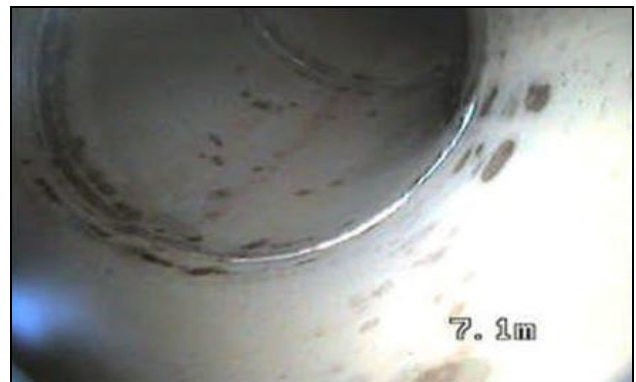
Rysunek 4. System 4 - wyraźne zanieczyszczenie, zwłaszcza w pobliżu spoin spawalniczych, spowodowane prawdopodobnie przez wbite tlenki żelaza.
