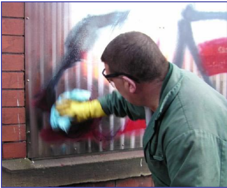
Voorzichtigheid is geboden bij het verwijderen van bijvoorbeeld graffiti op RVS
