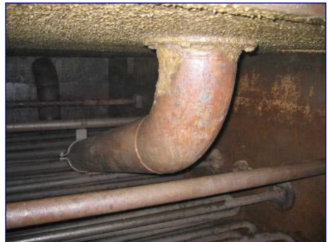
Foto 3: Smeerolie tank (25 m 3 ) na reinigen.
