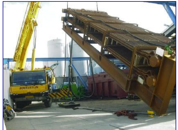
Pre-commission cleaning van een warmtewisselaar m.b.v. VPX One Step ®
