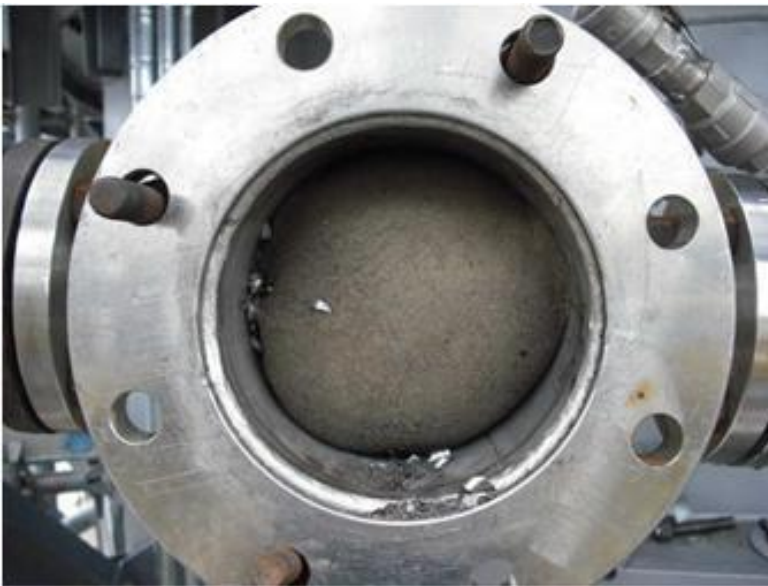
Terugkeer van de pig in de ontvanger
