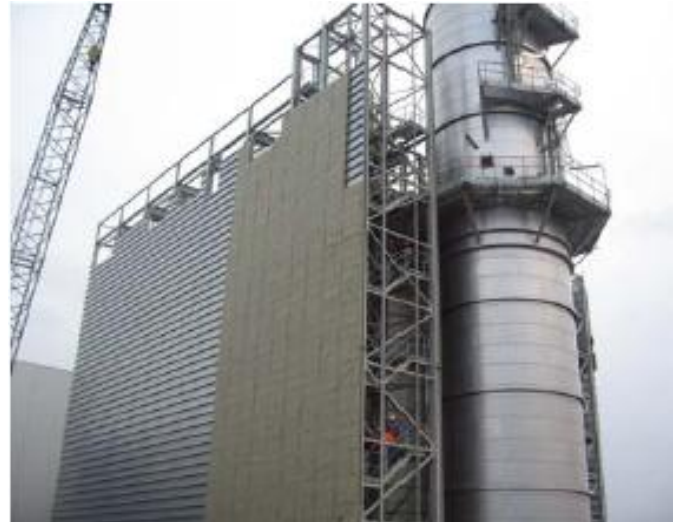
Foto 1: Unit 4 van Flevo Power in aanbouw
