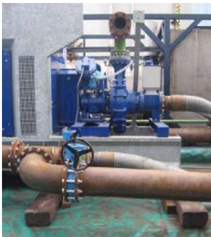
Foto2: Opstellen van de reinigungsapparatuur (850 m 3 /h pomp met dieselaandrijving)
