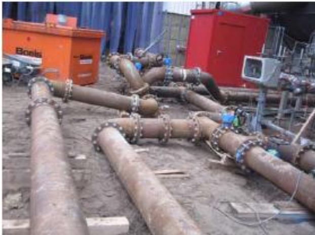
Foto 3: Tijdelijke leidingen voor chemische reiniging (DN250)
