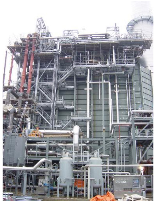
Reiniging ter plaatse
