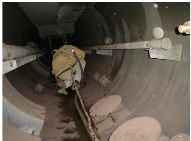
Figuur 2: Stoomdrum na beitsen en passiveren
