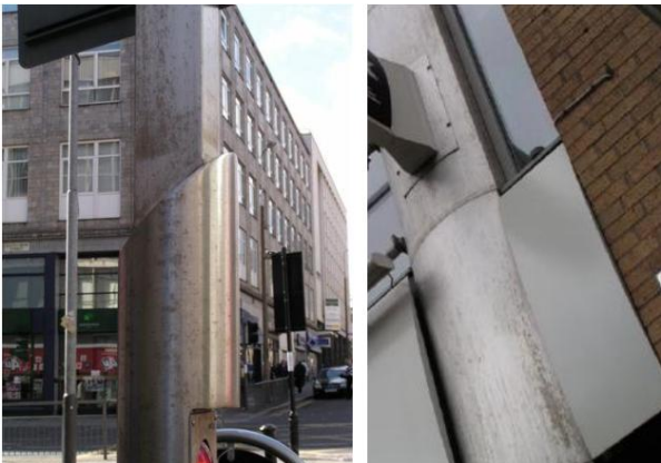
Afbeeldingen boven en onder: "Theevlek" corrosie op openbare RVS objecten
