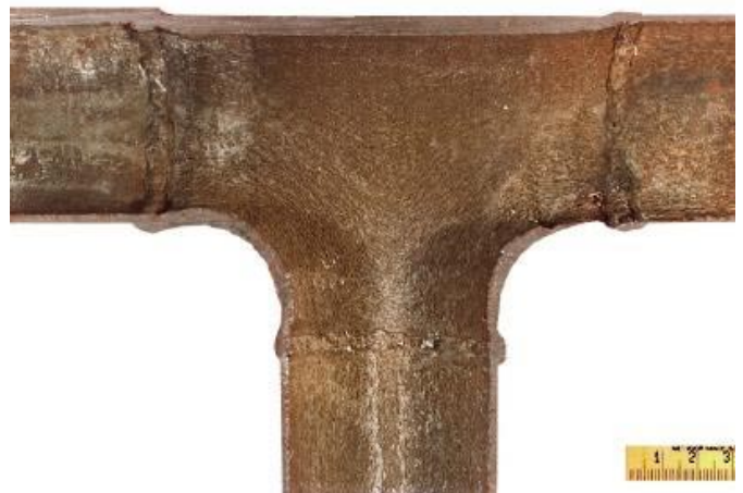
Figuur 10: Erosie-corrosie in T-stuk uit zwavelzuur leiding
