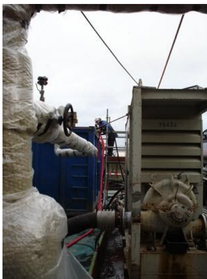
Standaard opstelling bij het chemisch reinigen van een stoomketel
