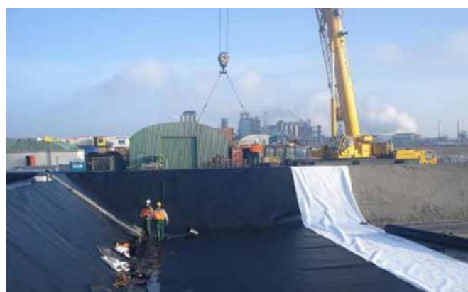
Neerleggen van folies met een kraan: eerst de witte beschermfolie, vervolgens de zwarte EPDM folie
