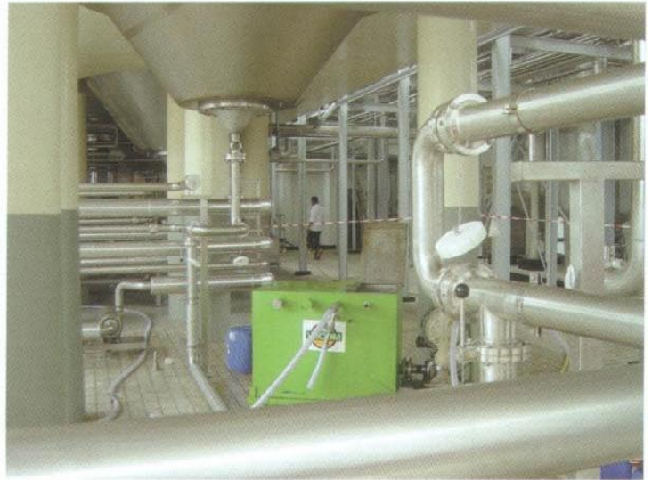
Afbeelding 1 Reiniging leidingwerk middels circulatie op locatie bierbrouwerij Parbo.
