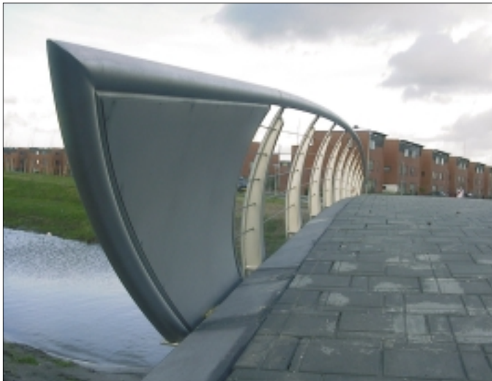
Een mooi voorbeeld van een keramisch geparelde brug, waarbij duidelijk het uniform, zijdeglans uiterlijk opvalt
