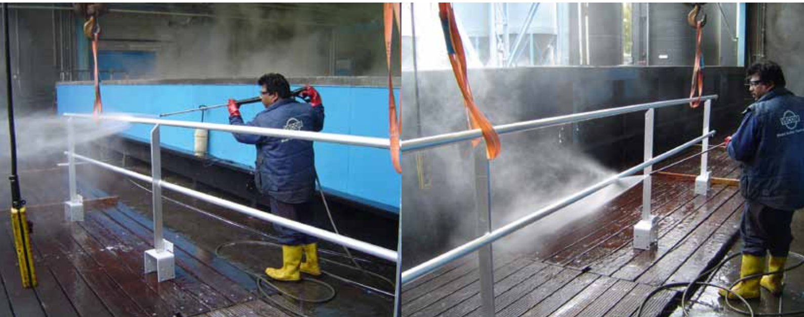
Sproeibeitsen en hogedrukafspuiten van aluminium leuningwerk
